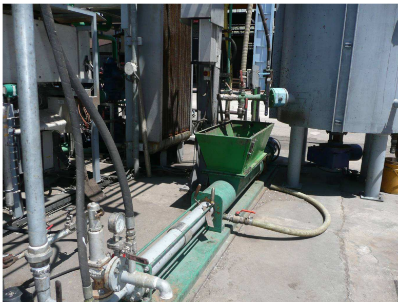
Fig. 41: Pompa Novarotors - vista d'insieme
